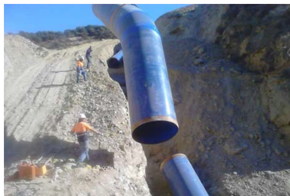
Vista de instalación de tubería con gran pendiente
