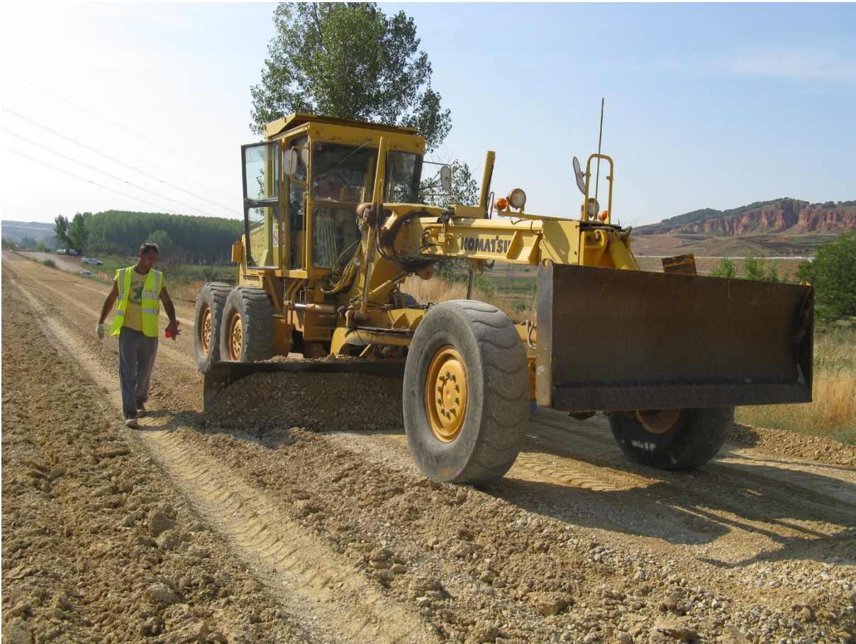
Figura 22. Extensión de material filtro en una presa
