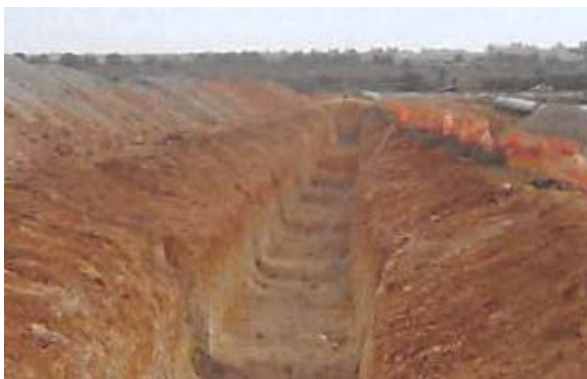
Vista de excavación en zanja y sobreanchos para soldadura
