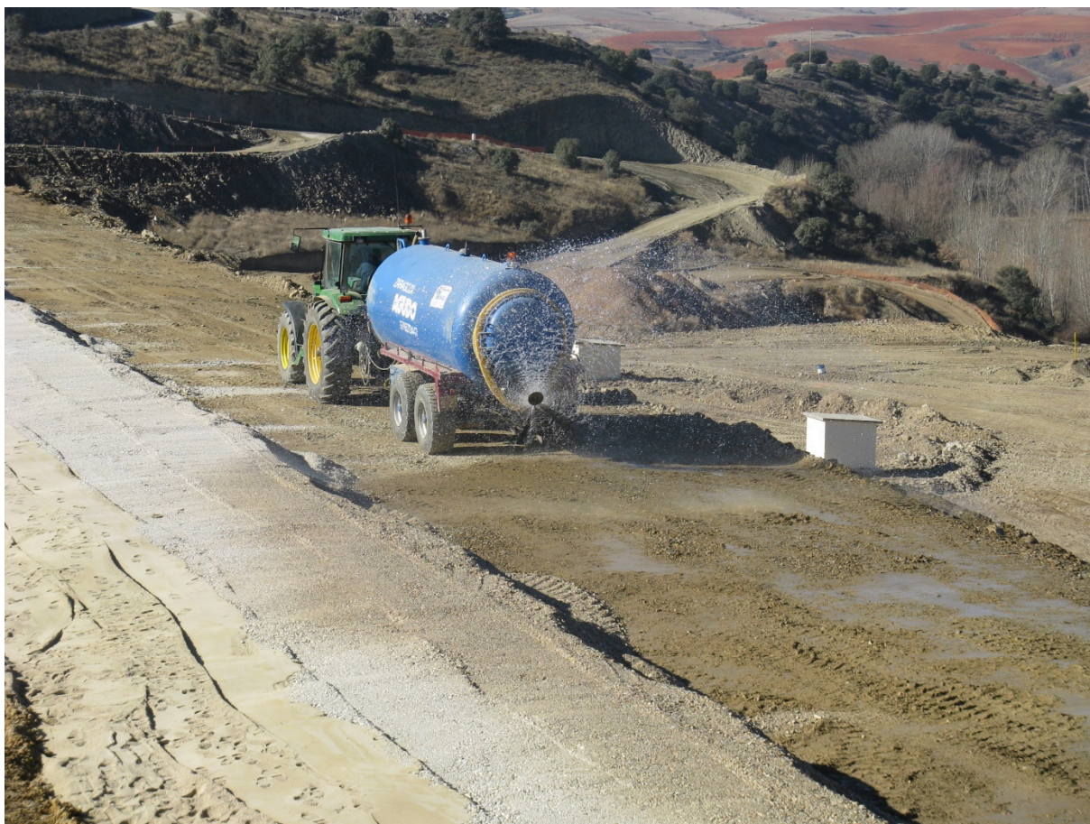
Figura 16. Humectación de una tongada
