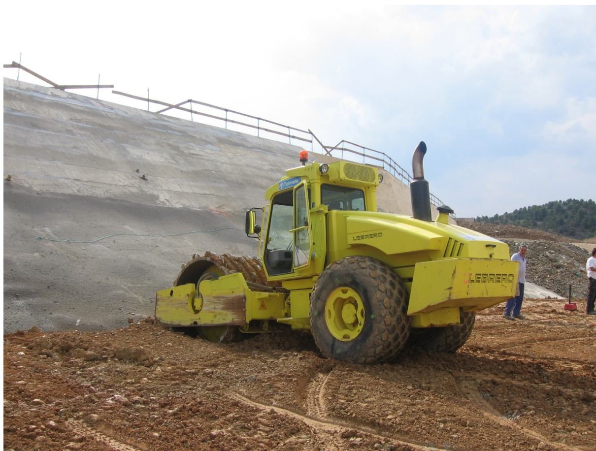
Figura 21. Compactación al lado de una obra de fábrica
