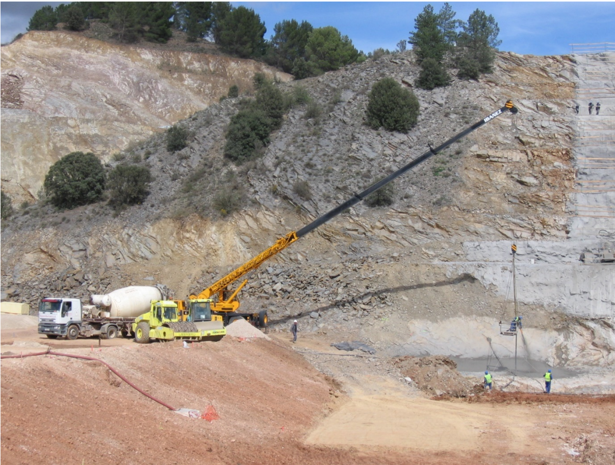
Figura 4. Fotografía de sellado con hormigón proyectado en presa
