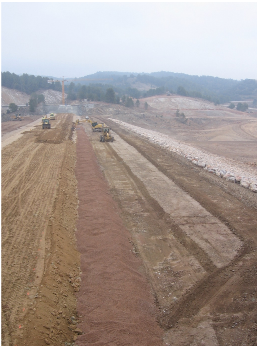
Figura 14. Secuencia de construcción en una presa de materiales sueltos
