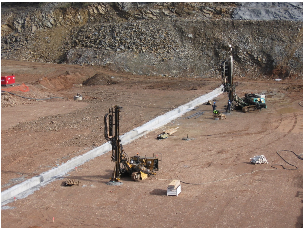
Figura 26. Equipos de inyección trabajando en una presa
