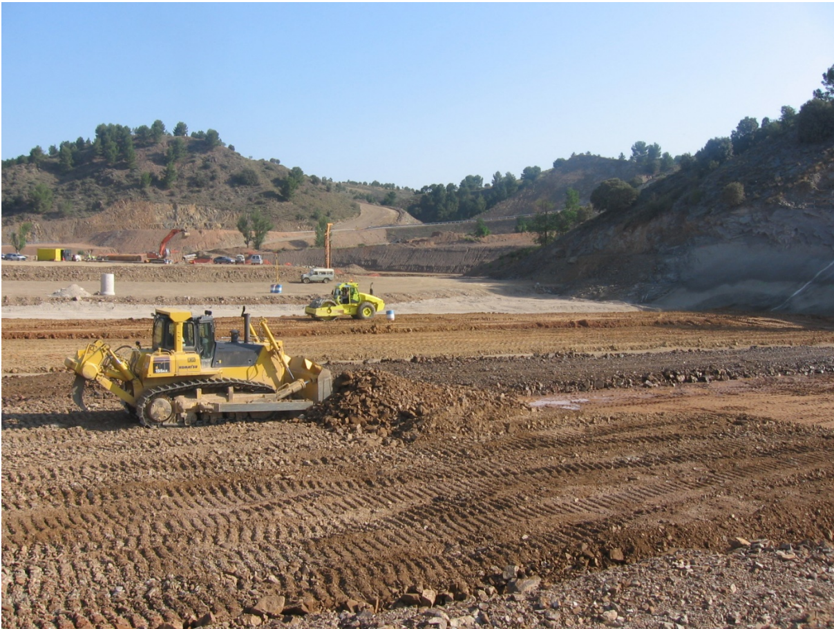
Figura 18. Extendido del material arcilloso en un núcleo de presa
