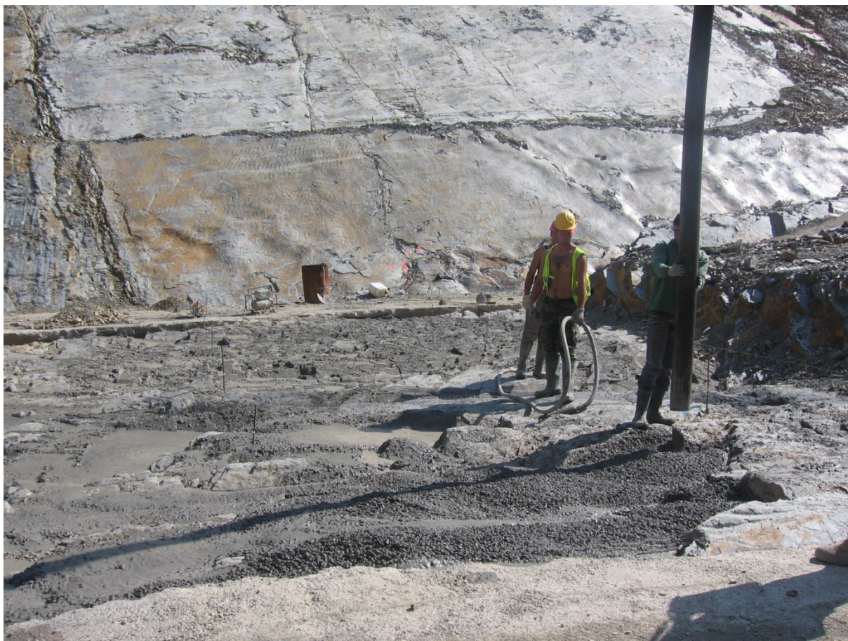
Figura 17. Regularización del cimientó de presa
