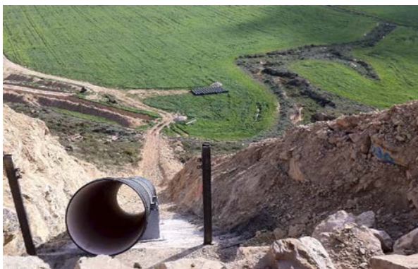
Vista de instalación de tubería con gran pendiente
