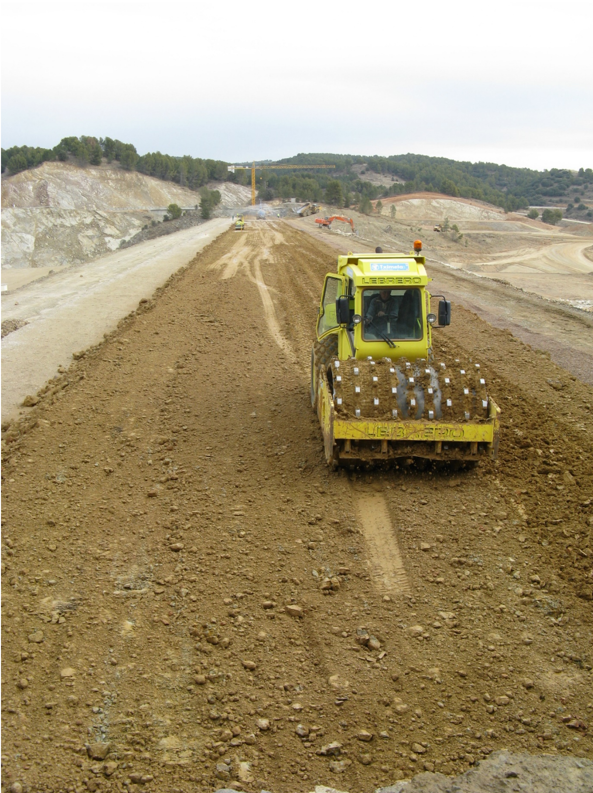
Figura 19. Compactación en dirección longitudinal al eje de presa
