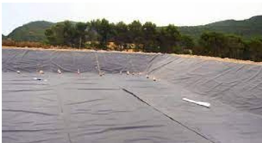
Figura 1. Balsa impermeabilizada con PEAD
