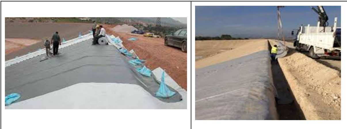
Figura 2. Preparación para anclaje en coronación de lámina PEAD
