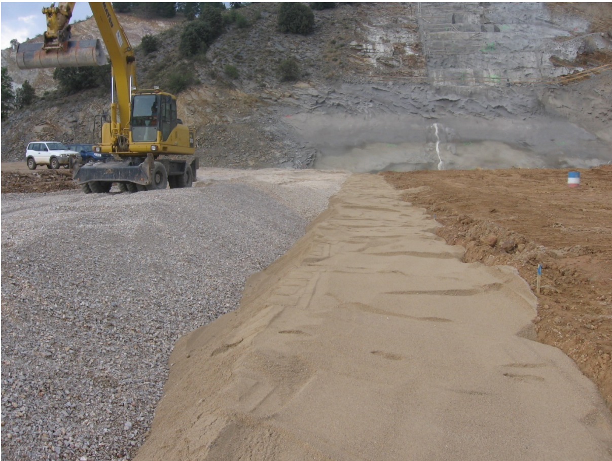
Figura 15. Disposición material filtro y dren en una presa
