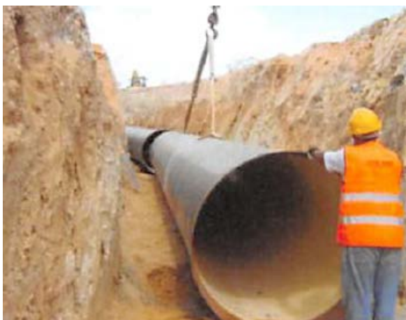
Alineación de tuberías
