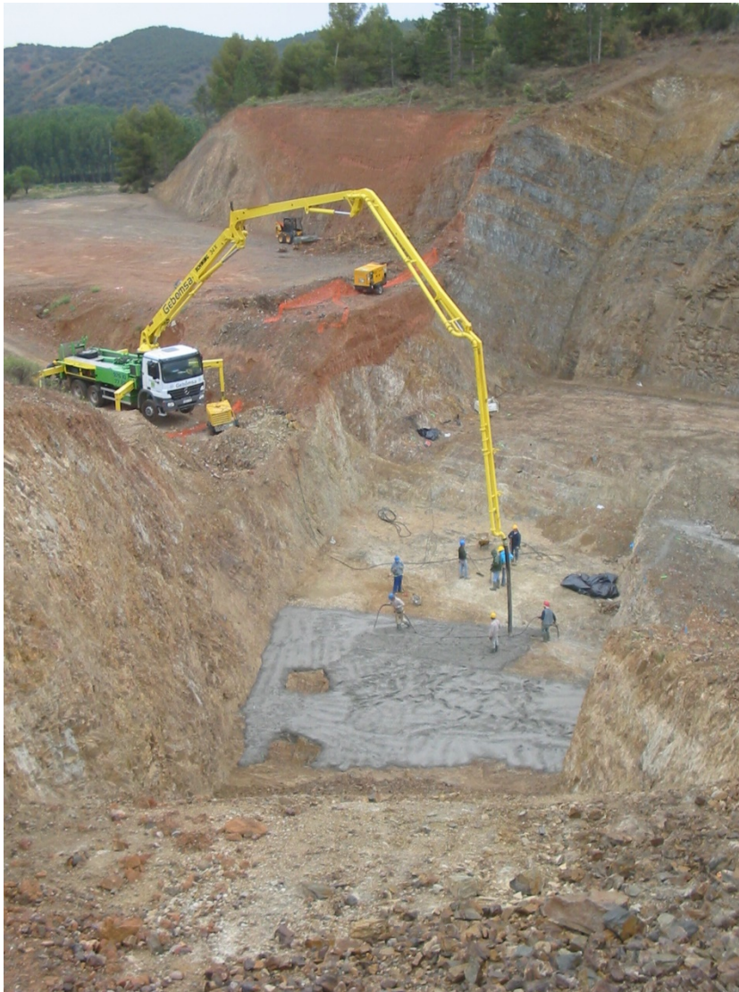
Figura 2. Fotografía de regularización en cemento de una presa
