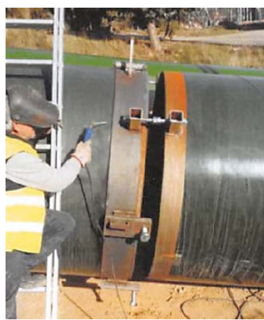
Vista de acopladores y alineación de tubería
