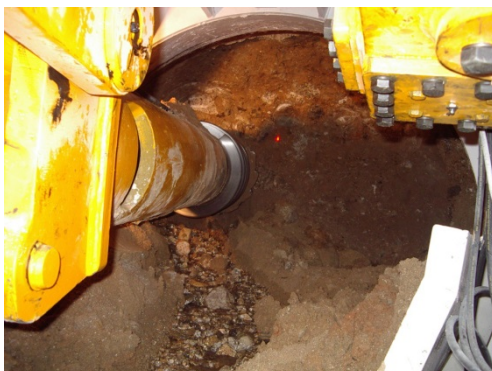
Brazo rozador trabajando en el frente de excavación
