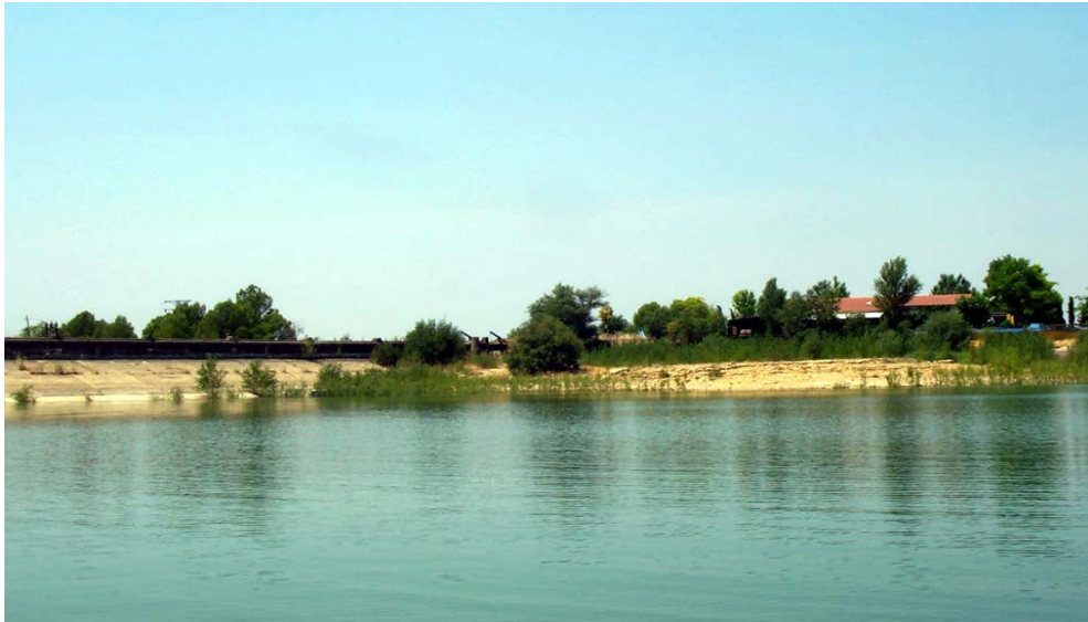
Vista de la presa desde la estación de muestreo (E1). Verano de 2004 (30/07/2004)
