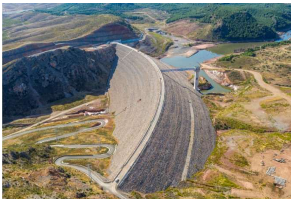
Foto 1: Presa de Mularroya (2020).
