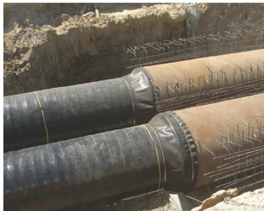
Una vez que la tubería se inserta dentro de la vaina, se deben instalar dos cierres elásticos en ambos extremos para sellar la hinca.
