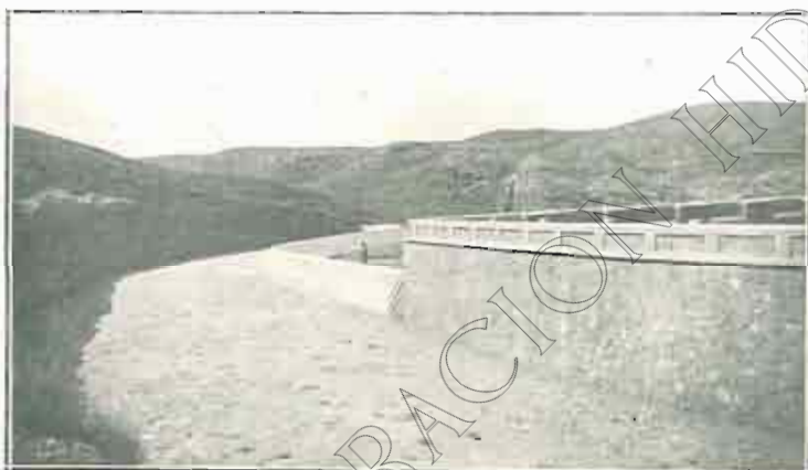
Aliviadero, presa vertedero y canal de evacuación.
