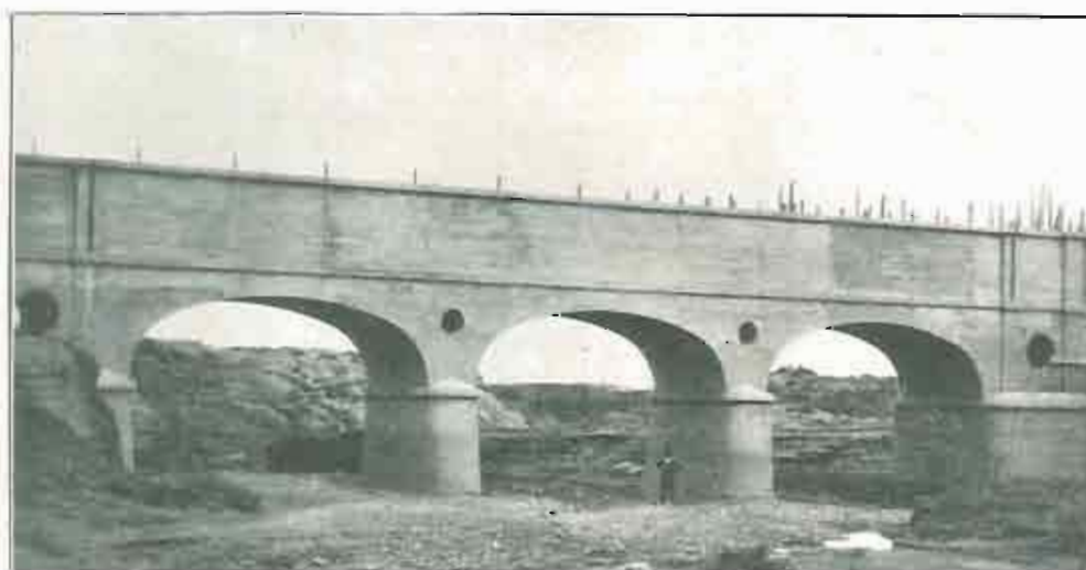
Acueducto sobre el "Recuenco", terminado. (Sección II)
