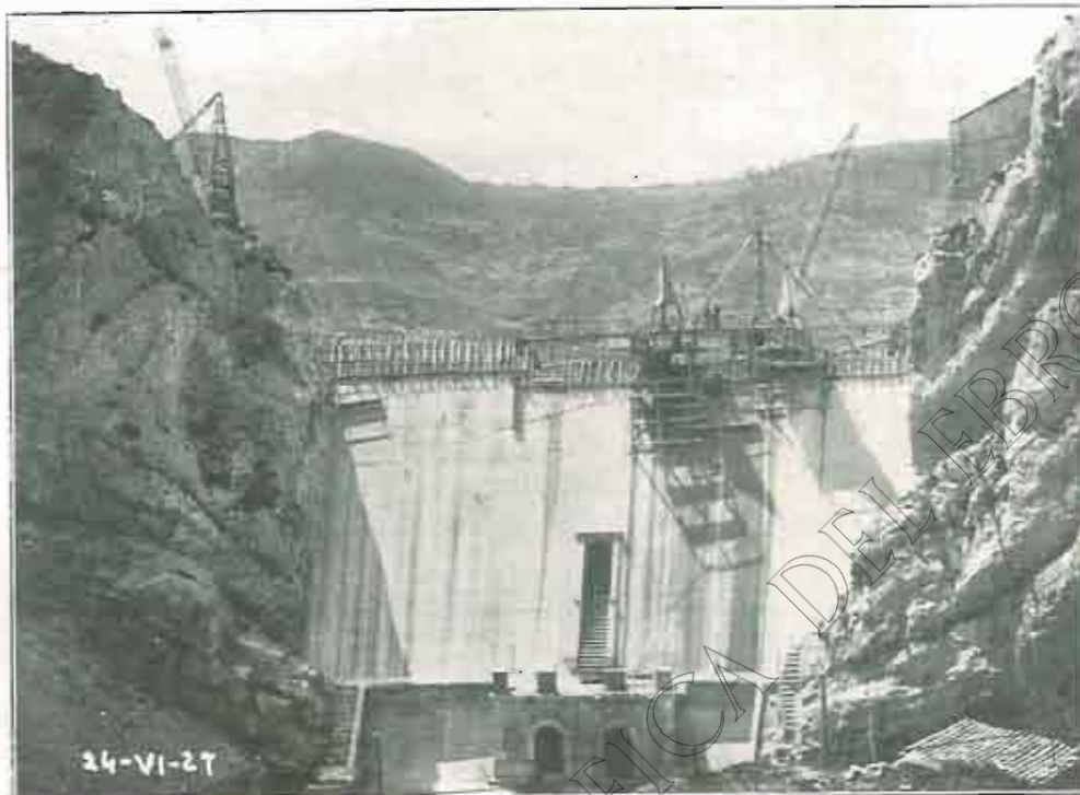
Vista del paramento de aguas abajo en el estado actual de las obras.
