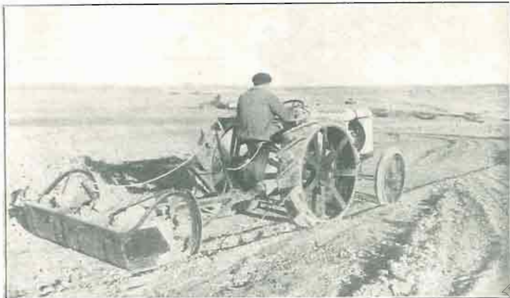
Equipo "Fordson-Schacfer" realizando trabajos de nivelación.
