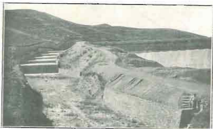
Aliviadero: Saltos y canal de descarga.
