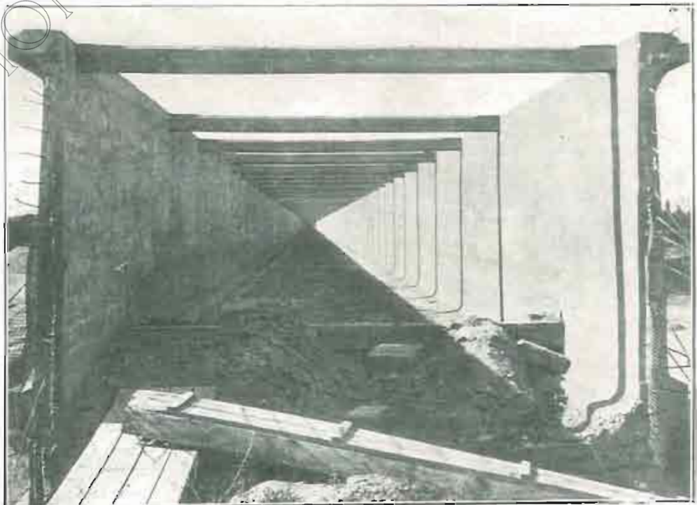
Acueducto sobre el río Cidacos (Sección I)
