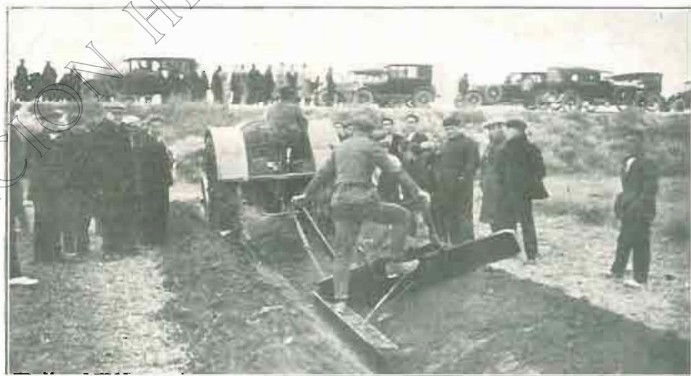
Trabajos de apertura de zanjas, realizados por un tractor "Deering", arrastrando un abrezanjas "Martín",
