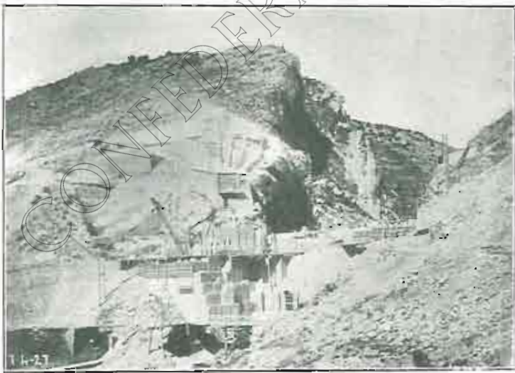
PANTANO DE PENA: Detalles de construcción. — Paramento de aguas-arriba.
