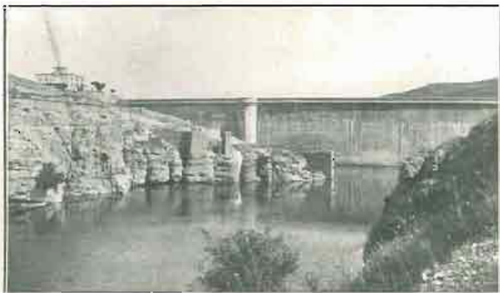
Presa de embalse y torre de toma.
