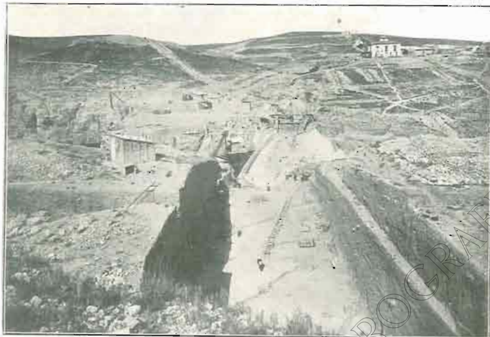
Vista general de las obras e instalaciones.
