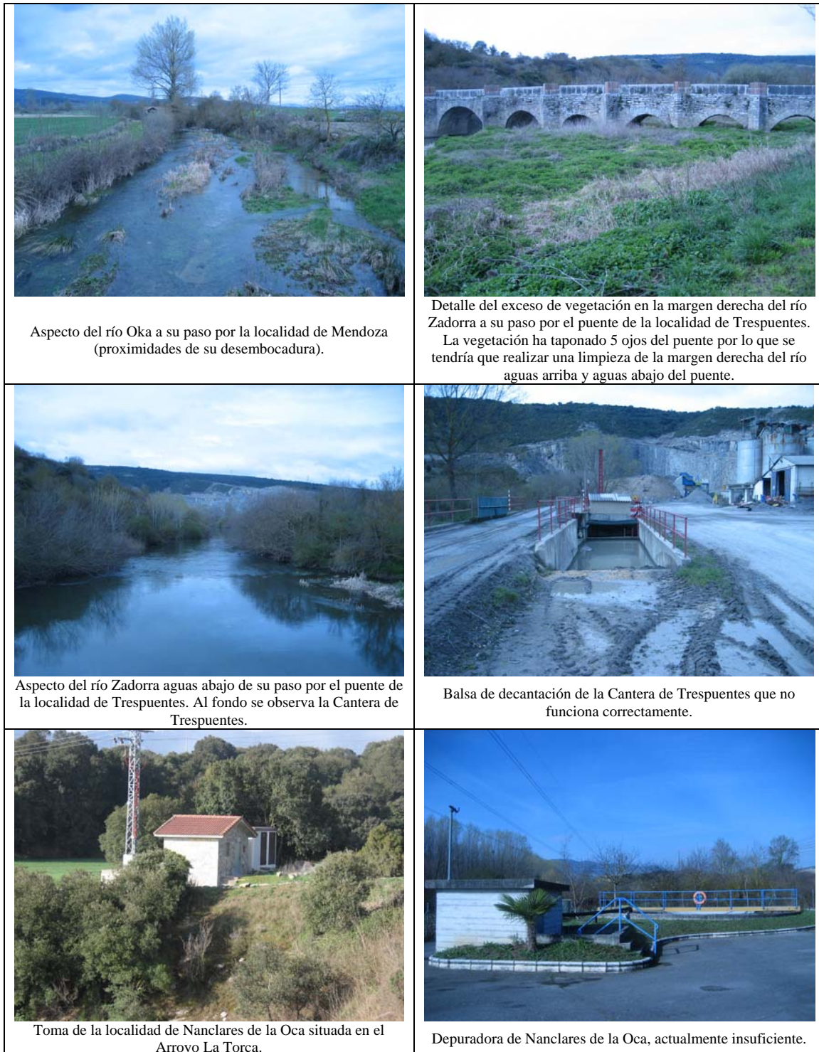
Figura 3.15: Fotos representativas de las características y problemas en el río Zadorra desde el río Zayas hasta las surgencias de Nanclares (incluye el río Oka) (249)
