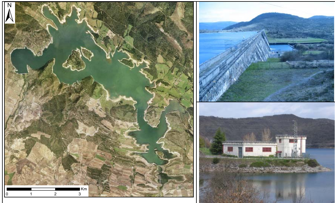
Figura 2.43: Embalse de Ullivarri. Fotos de la presa del embalse y de la toma de AMVISA (marzo 2008).
