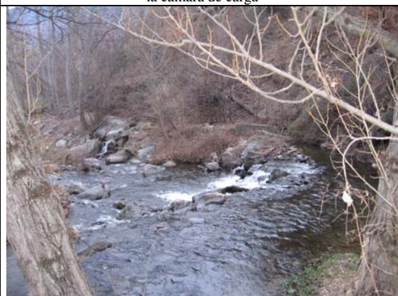
Central Hidroeléctrica de San Antonio en río San Antonio. Azud de derivación que se encuentra en el río una vez que se ha producido el vertido de la central. La derivación se realiza por la margen derecha
