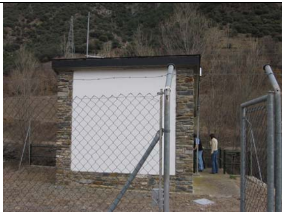
Estación de aforos del Noguera Ribagorzana en Escaló. Caseta de la estación
