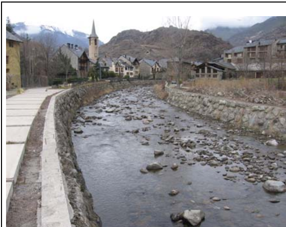
Canalización y central de Esterri+Unarre. Canalización de Sterri. Esta canalización ha sido polémica. Esterri d'Aneu tiene 9 manantiales para suministro de agua de boca. Solicitaron la concesión, pero como no respondieron a un requerimiento de la CHE no se ha regularizado esta concesión. Parece que el tema está pendiente de resolver.
