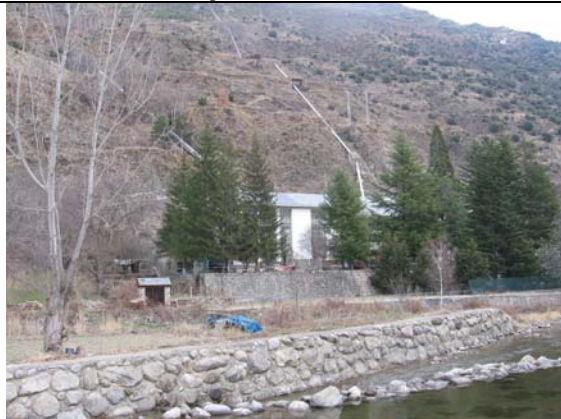
Canalización y central de Esterri+Unarre. Central Hidroeléctrica de Sterri (21 m 3 /s), cuya toma de agua se encuentra en el embalse de Boren, y Unarre (6 m 3 /s), cuya toma de agua se encuentra en el río Unarre.
