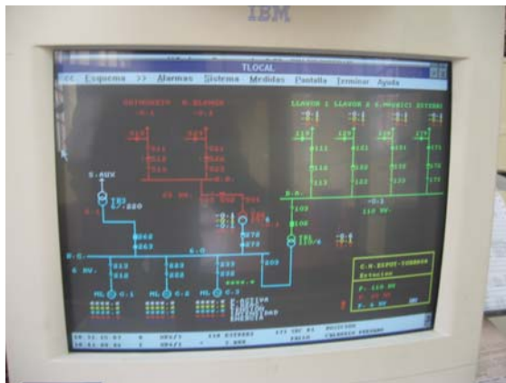
Central de Spot-Torrassa. Panel de control de las centrales de la cabecera del Pallaresa
