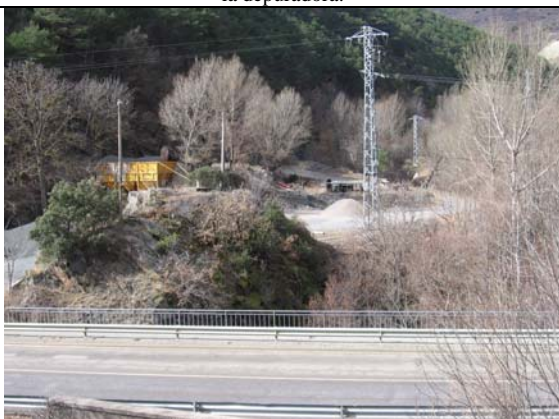
Planta de tratamiento de áridos en la desembocadura del río Spot.
