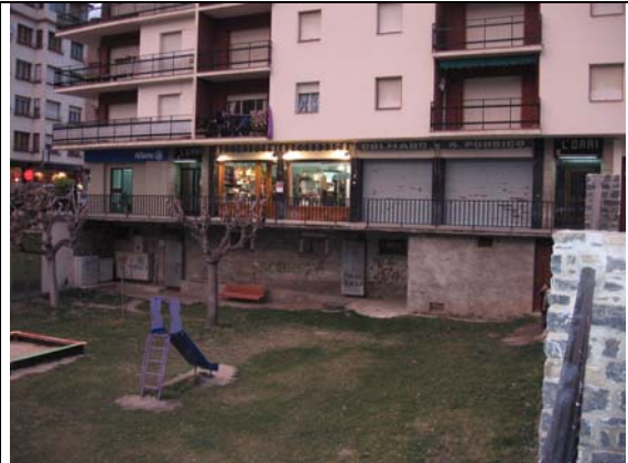
Edificio en el cauce abandonado
