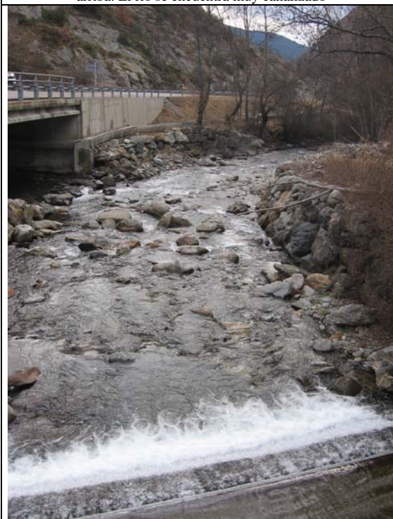
Desembocadura del Noguera de Tor en el Valfarrera. Vista del Valfarrera desde la estación de aforos hacisa aguas abajo. En el puente de la izquierda se produce la desembocadura del río Noguera de Tor.
