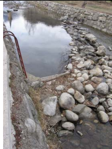
Canalización y central de Esterri+Unarre. Azud de gravas en la canalización de Esterri
