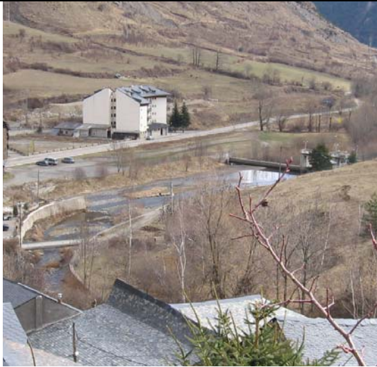
Azud central hidroeléctrica de Spot. Vista del azud desde la carretera de La central
