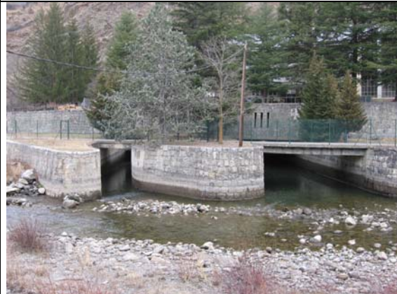
Canalización y central de Esterri+Unarre. Detalle de la salida de las dos centrales
