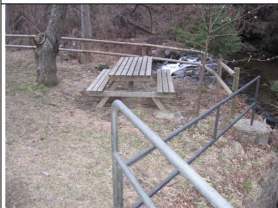
Central Hidroeléctrica de San Antonio en río San Antonio. Mesas instaladas en la ribera a la altura de la central
