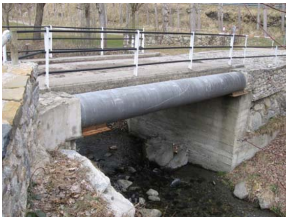
Camping aguas abajo de Spot. Puente que cruza el río para acceder al camping. Paso del colector de aguas residuales hacia la depuradora.
