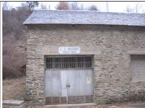
Central Hidroeléctrica de San Antonio en río San Antonio. Instalaciones de la central. La central es de 1958.
