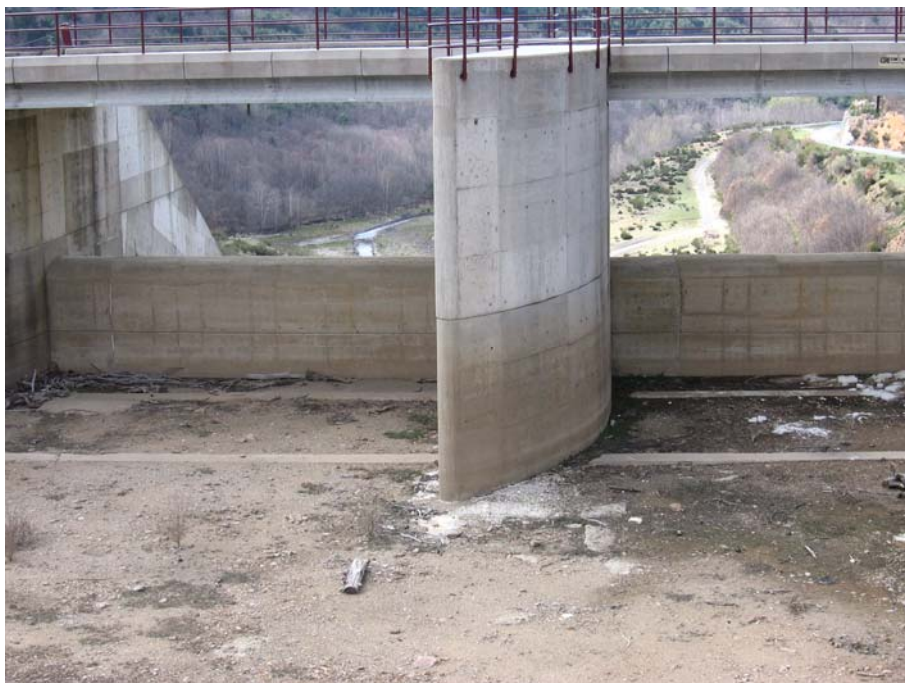
Ref. 6.- Presa de Pajares - Aliviaderos.
