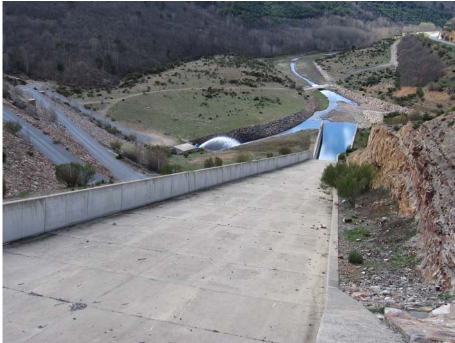
Ref. 1.- Presa de Pajares - Salida desagüe de fondo y aliviaderos.
