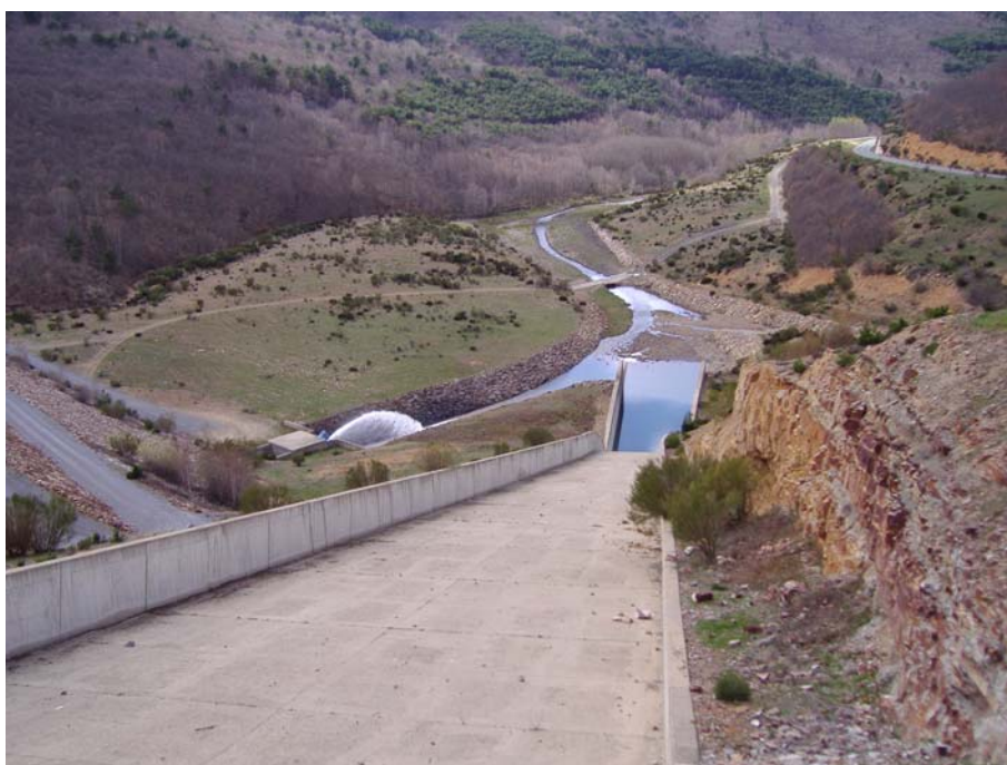
Ref. 14.- Presa de Pajares - Salida desagüe de fondo y aliviaderos.
