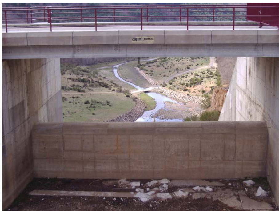
Ref. 11.- Presa de Pajares – Aliviaderos.
