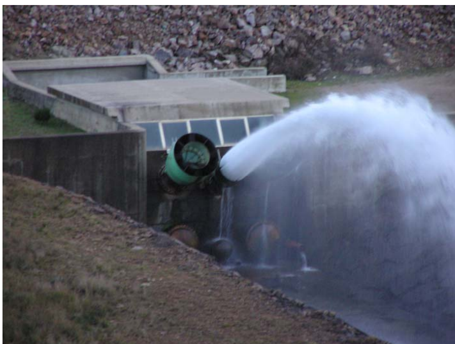
Ref. 22.- Presa del Embalse de Pajares - Desagüe de fondo.
