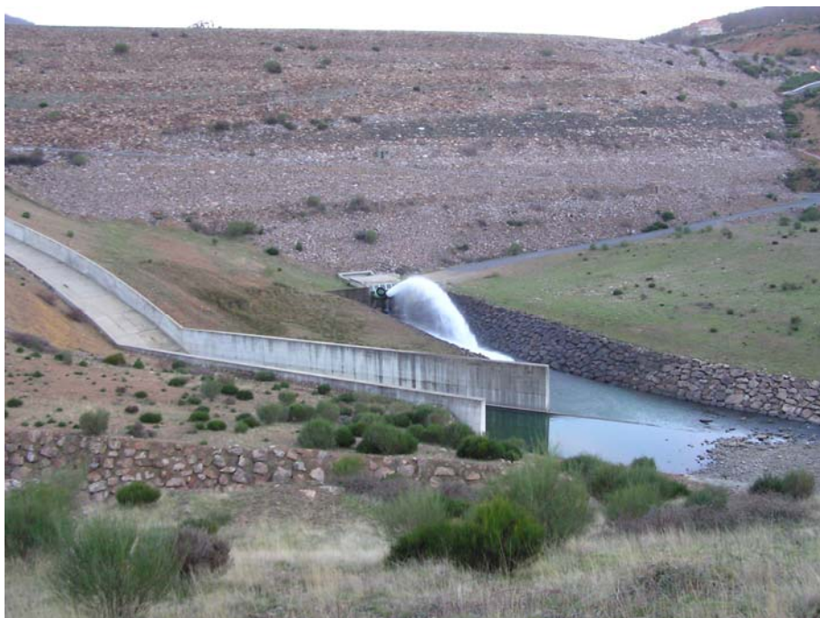
Ref. 21.- Presa del Embalse de Pajares - Aliviadero y desagüe de fondo.
