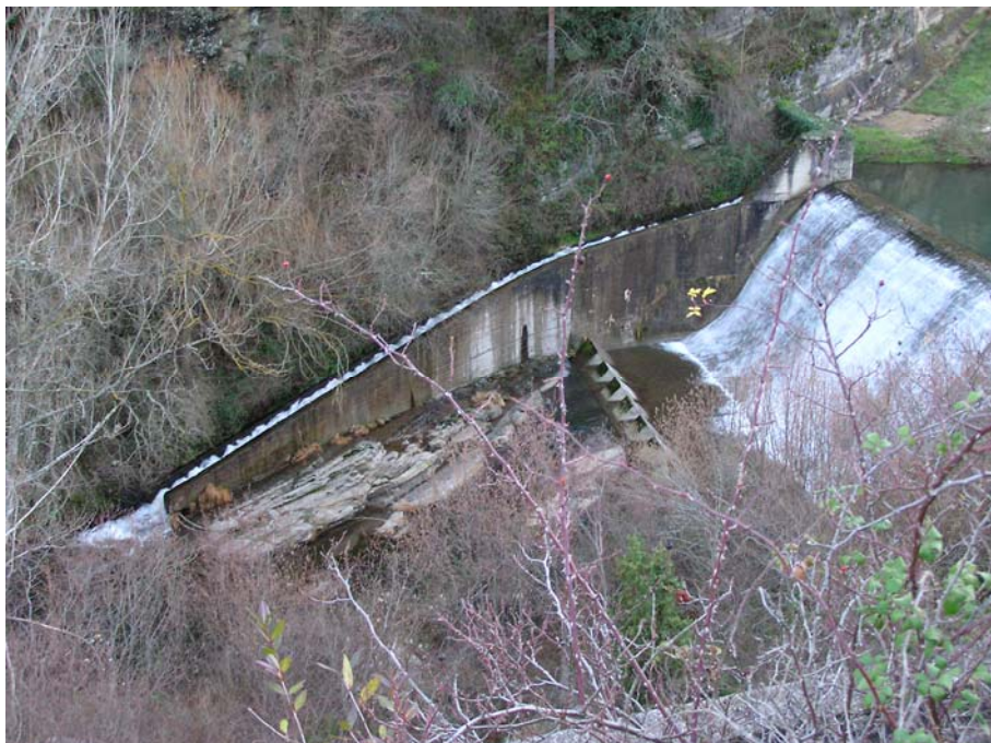
Ref. 56.- Azud Canal Alimentador Traslase al Embalse de Ortigosa.
