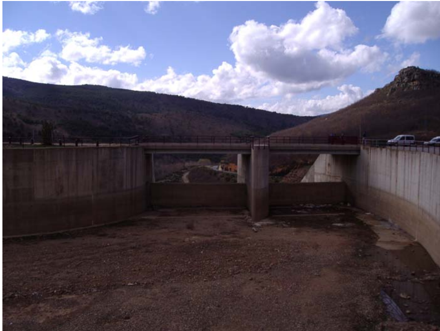
Ref. 9.- Presa de Pajares – Aliviaderos.
