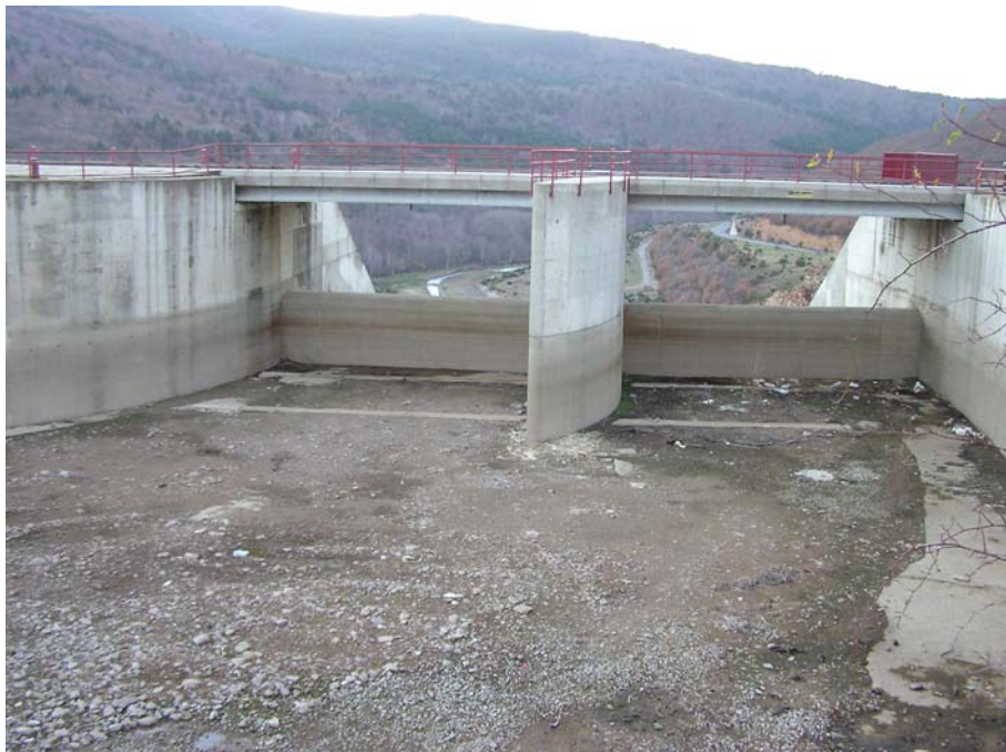
Ref. 20.- Presa del Embalse de Pajares – Aliviadero.
