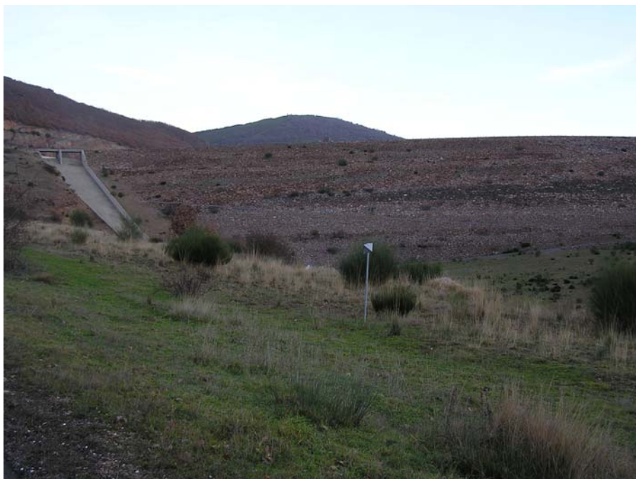
Ref. 25.- Presa del Embalse de Pajares - Cuerpo de Presa.
