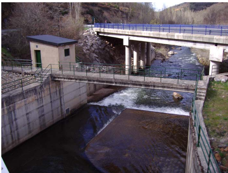
Ref. 61.- Estación de Aforos nº 35 en Villoslada de Cameros.
