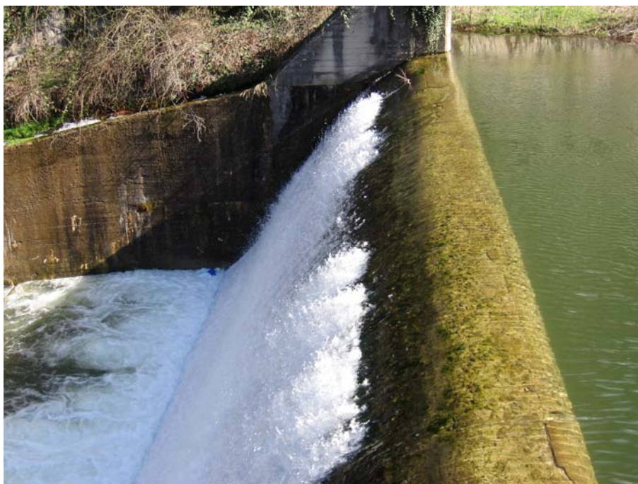
Ref. 45.- Azud del Canal Alimentador Trasvase al Embalse de Ortigosa.
