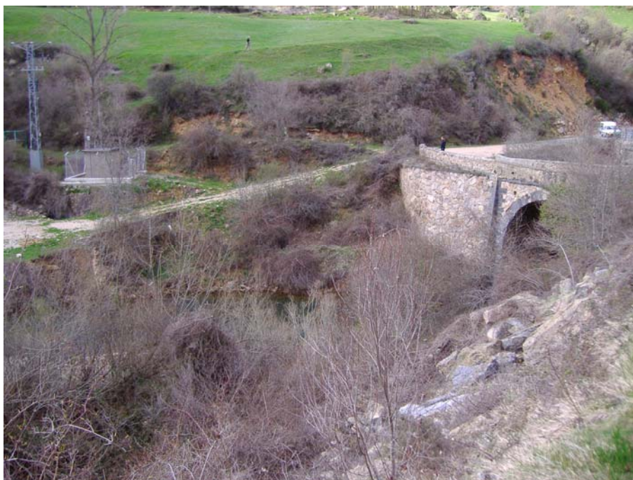
Ref. 39.- Caseta SAIH en margen izda. aguas arriba de la Toma Canal Alimentador Traslase Embalse Ortigosa.
