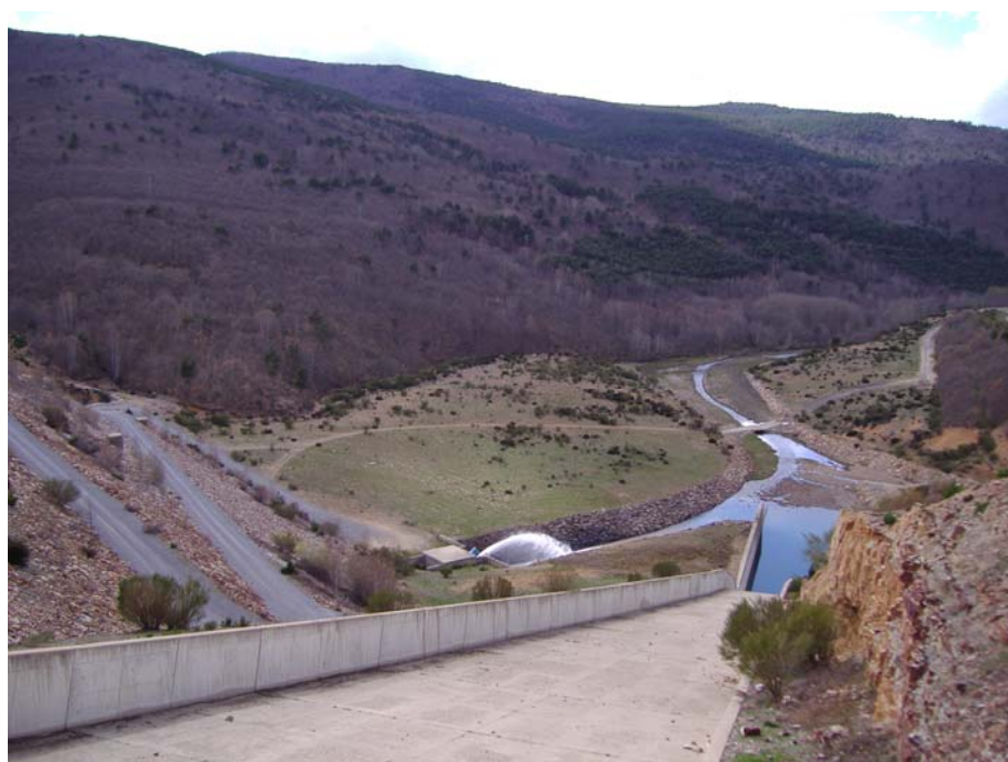
Ref. 16.- Presa de Pajares - Salida desagüe de fondo y aliviaderos.
