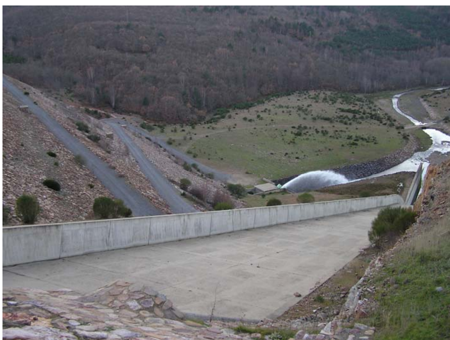
Ref. 24.- Presa del Embalse de Pajares - Aliviadero y desagüe de fondo.
