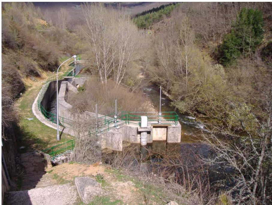
Ref. 50.- Azud y Toma del Canal Alimentador Traslase al Embalse de Ortigosa.
