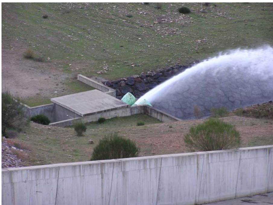
Ref. 23.- Presa del Embalse de Pajares - Desagüe de fondo.
