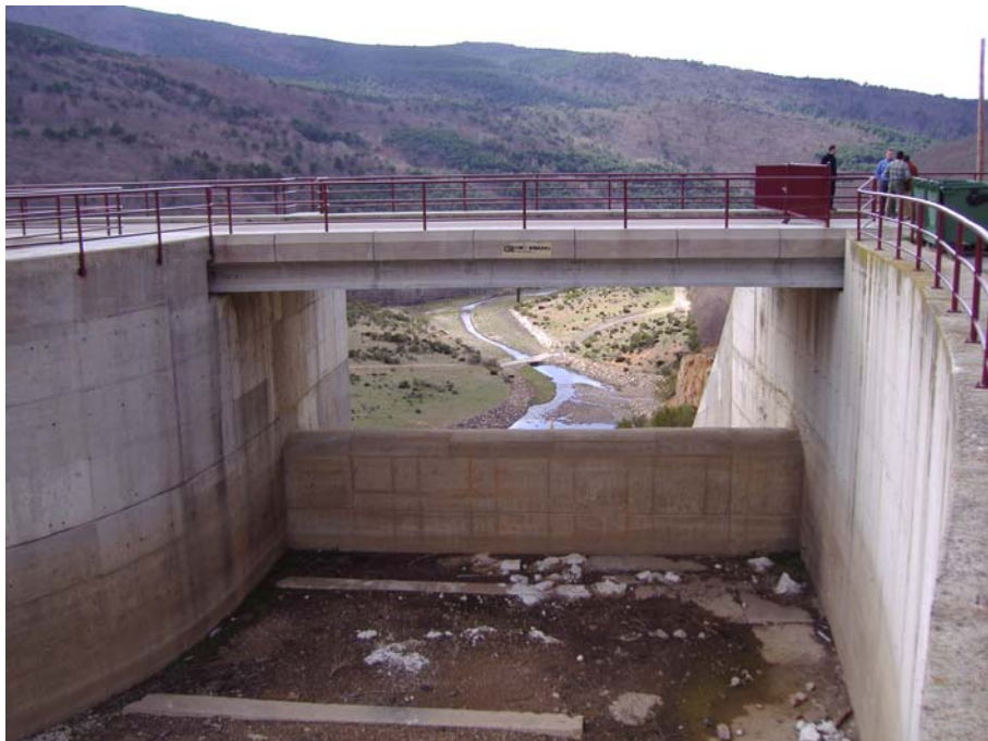
Ref. 10.- Presa de Pajares – Aliviaderos.
