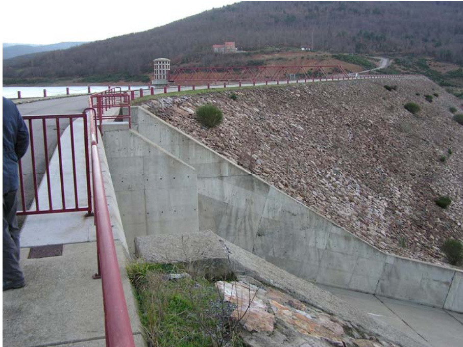
Ref. 19.- Presa del Embalse de Pajares - Cuerpo de Presa.
