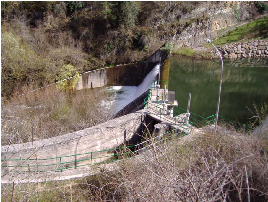
Ref. 51.- Azud y Toma del Canal Alimentador Trasvase al Embalse de Ortigosa.
