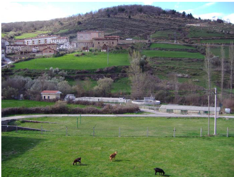
Ref. 37.- Estación depuradora de Villoslada de Cameros.
