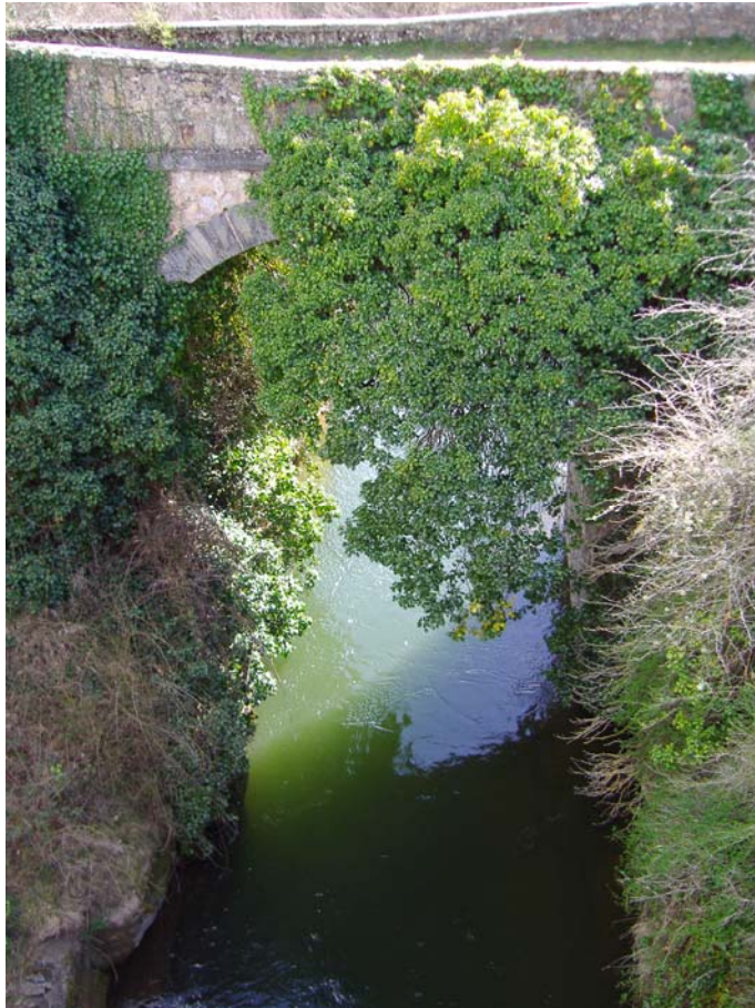
Ref. 49.- Puente viejo aguas arriba de la Toma del Canal Alimentador Traslase al Embalse de Ortigosa.
