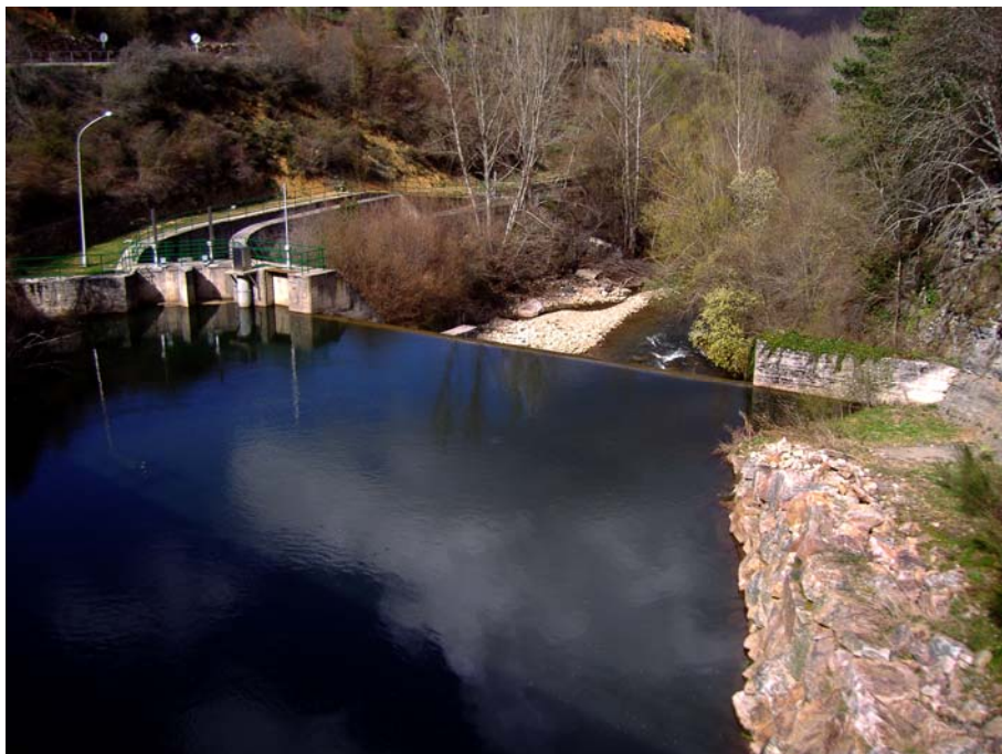
Ref. 48.- Azud y Toma del Canal Alimentador Traslase al Embalse de Ortigosa.
