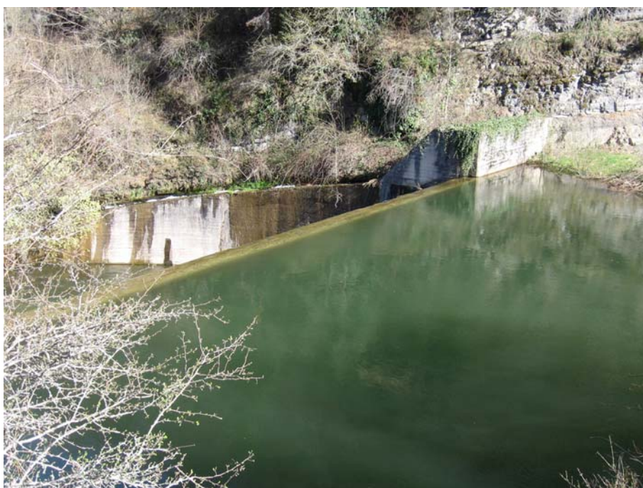
Ref. 42.- Azud del Canal Alimentador Trasvase al Embalse de Ortigosa.
