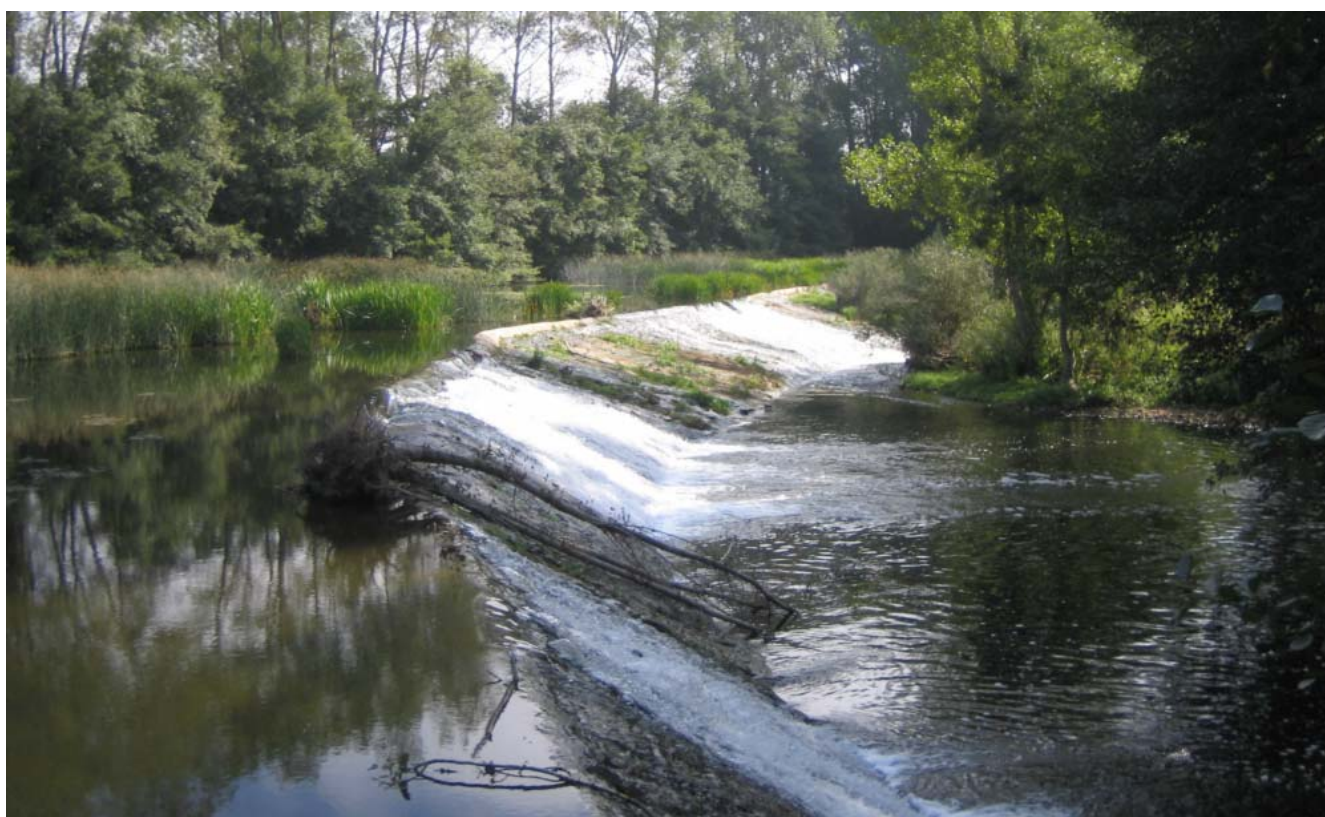
Fig. 5. Vista de la estructura desde la margen derecha del río Nela.
