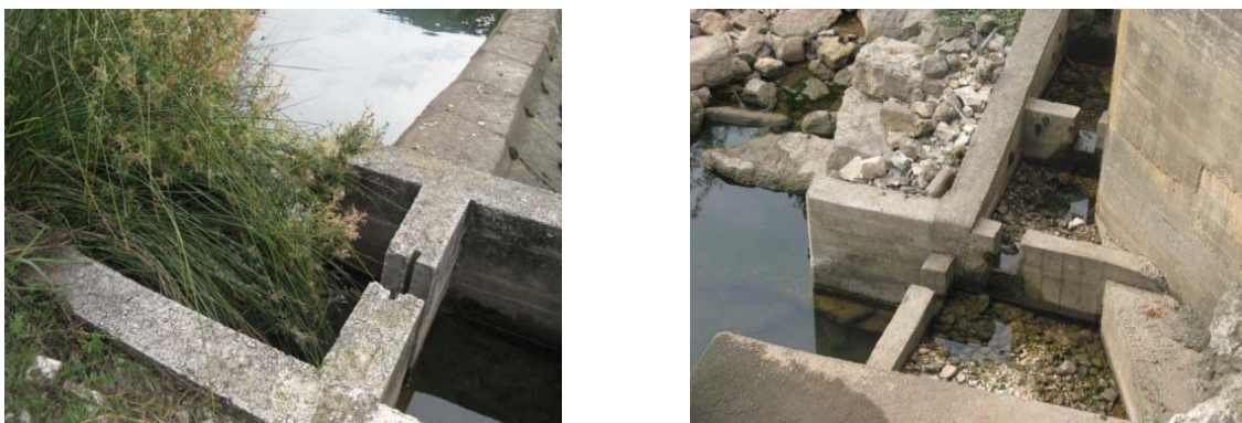
Fig. 9. Detalle de la entrada de caudal (izq) y de la entrada a la escala para los peces (derecha)
