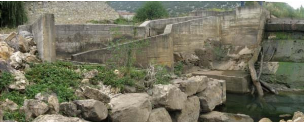
Fig. 8. Vista de la escala de peces de artesas sucesivas
