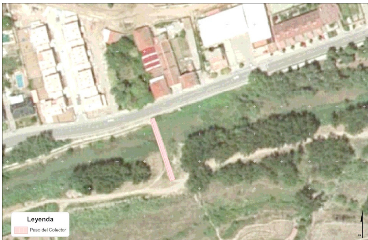
Fig. 5. emplazamiento del colector de aguas residuales sobre el río Guadalope de Alcañiz
