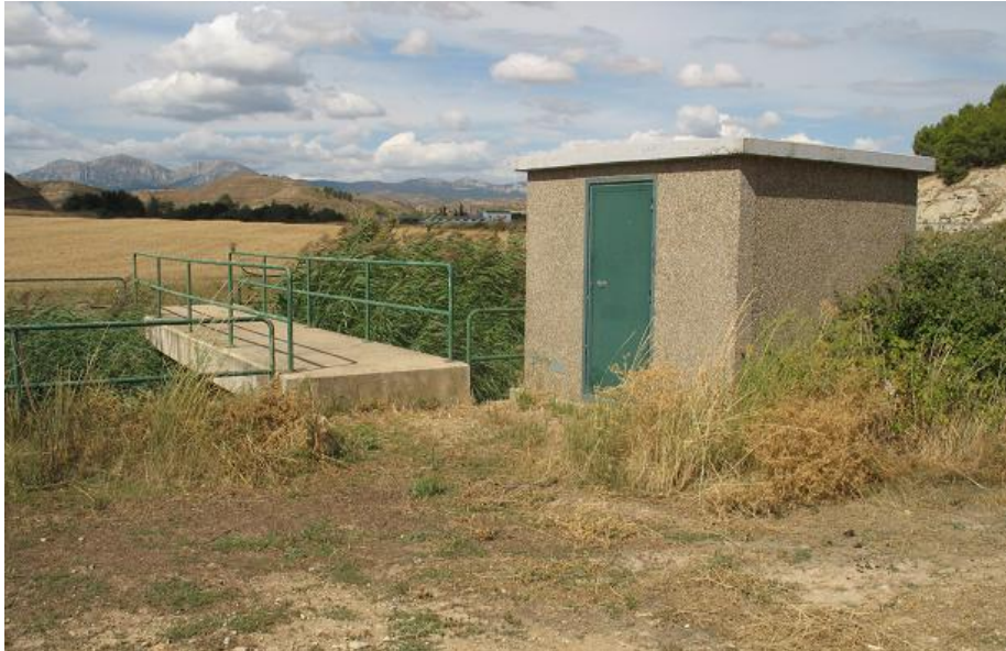
Figura 17-4. Estación de aforos en el cauce del río Linares.
