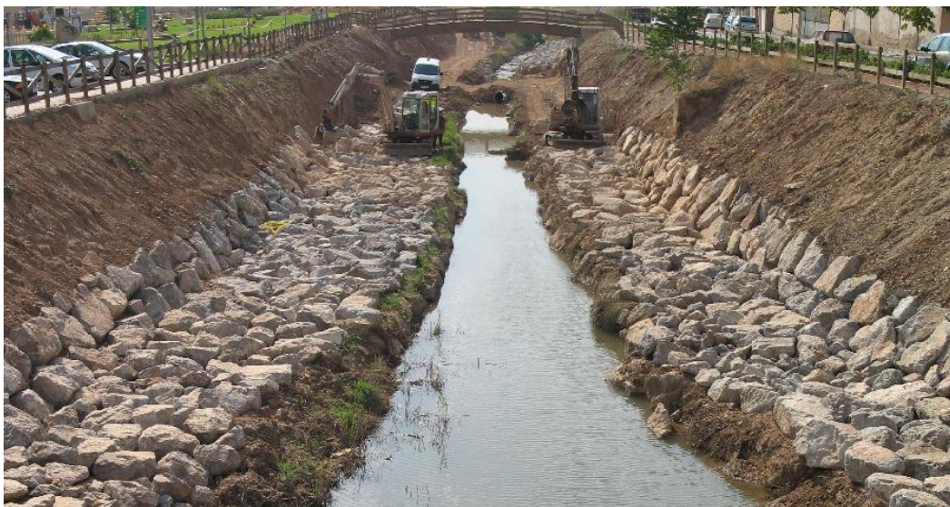
Figura 17-8. Canalización en la localidad de Mendavia.
