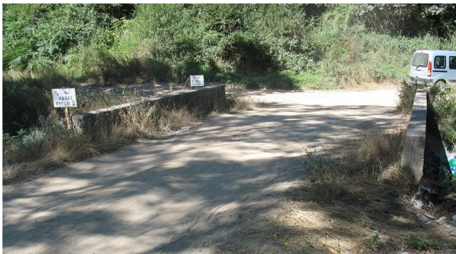
Figura 18-22. Puente en las inmediaciones de Santa Cruz del Río Urbión.
