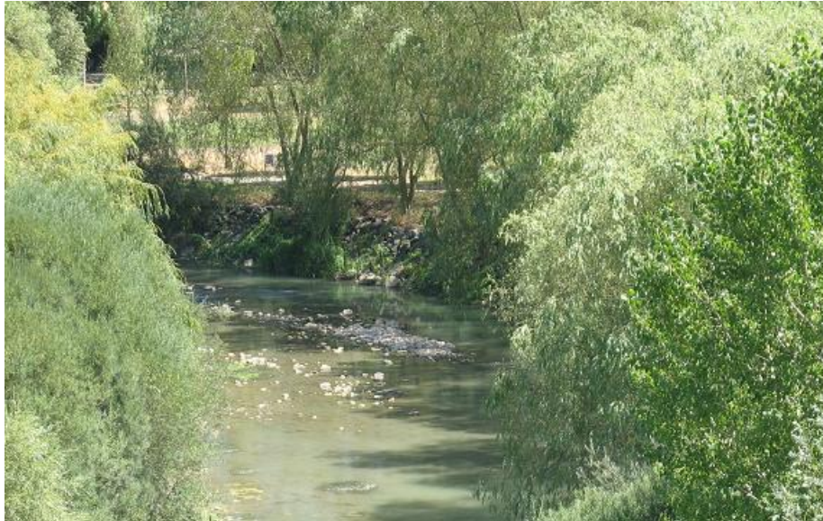
Figura 18-13. Defensas de margen y corredor ribereño aguas arriba de Leiva.
