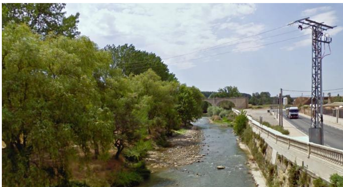
Figura 18-18. Cauce del río Tirón a su paso por Haro.
