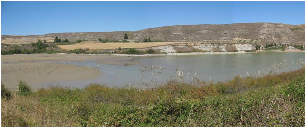
Figura 18-12. Vaso del Embalse de Leiva. Acumulaciones de sedimentos.
