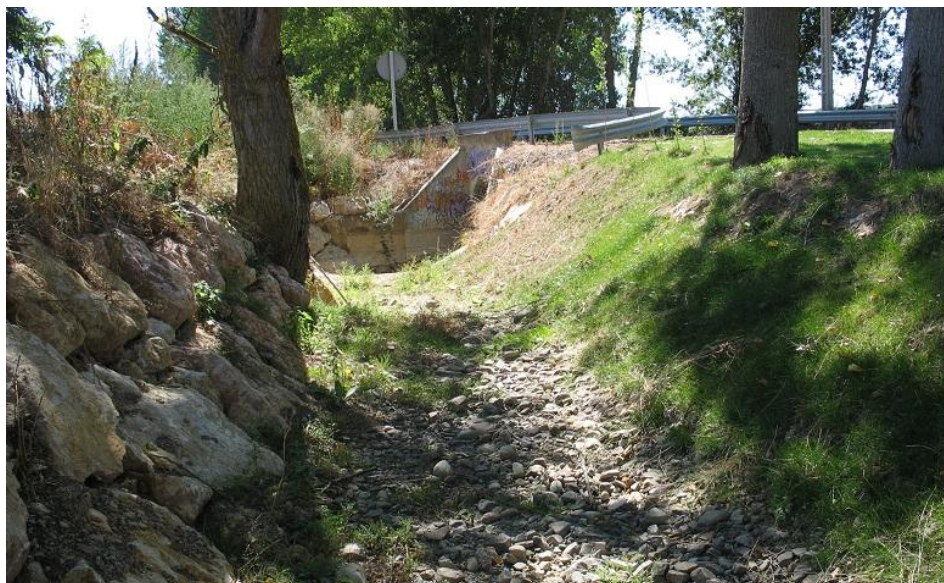
Figura 18-25. Escollera y alteración de márgenes en Villarta.
