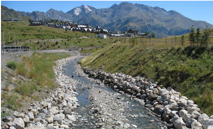
Figura 53-4. Canalización mediante escolleras en la zona de la estación de esquí de Aramón Formigal.
