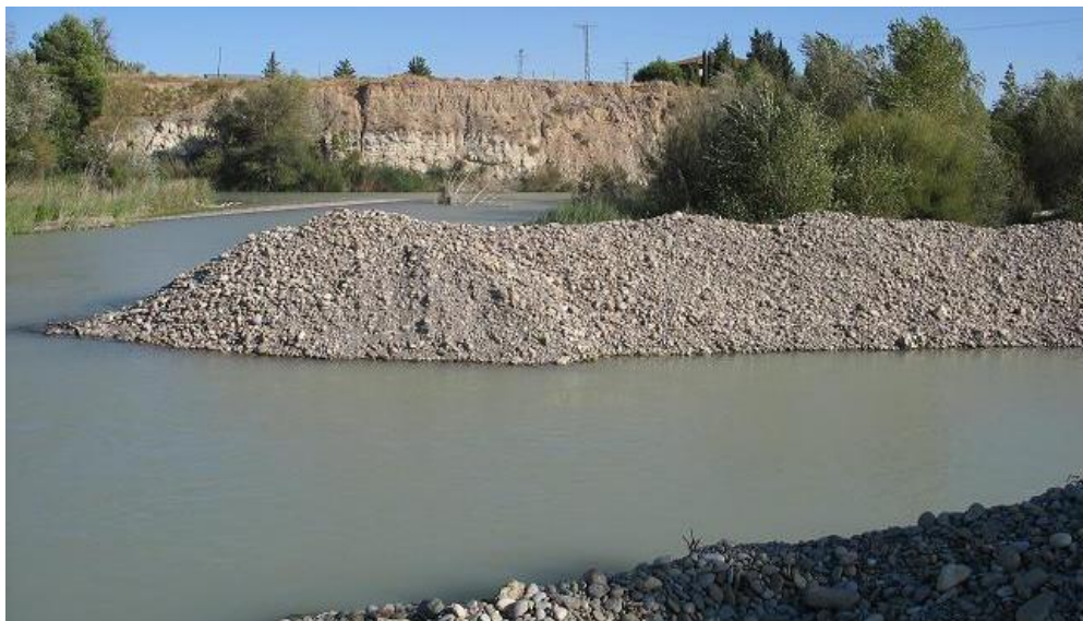
Figura 53-30. Vaso del azud de Camarera, con notables muestras de movimientos de material de fondo.
