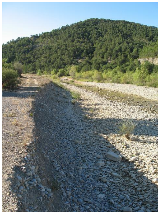
Figura 53-48. Pista forestal con erosión lateral.
