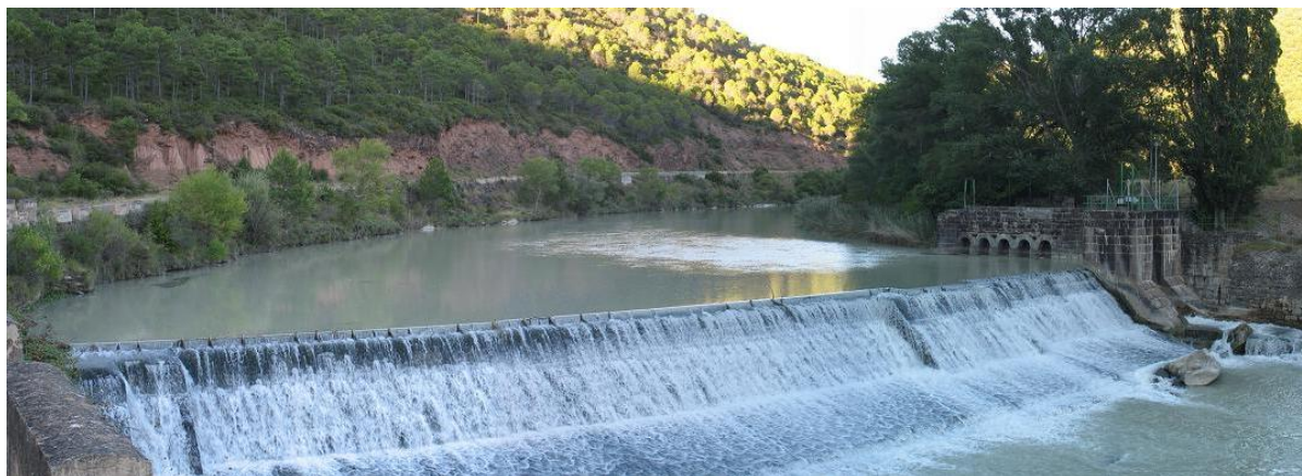
Figura 53-19. Azud de derivación en las cercanías del embalse de La Peña.
