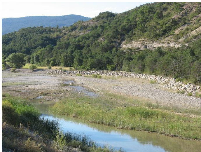
Figura 53-47. Cauce trenzado y defensa lateral en el cauce del río Guarga.
