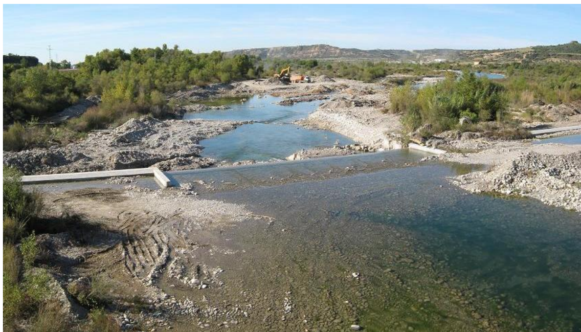
Figura 55-19. Dragado del río Cinca en Puente Las Pilas.
