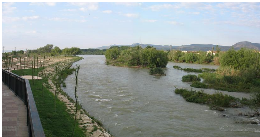
Figura 55-35. Río Cinca en Fraga. Defensas de margen y dragado del cauce.
