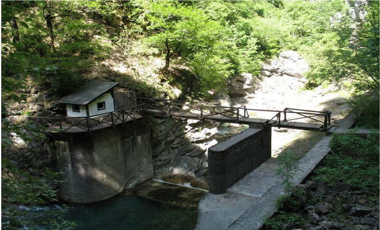
Figura 55-48. Pequeña estación de aforos en el río Bellós.
