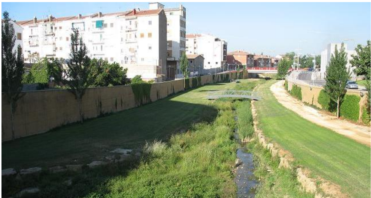
Figura 55-70. Canalización del río Sosa en Monzón.
