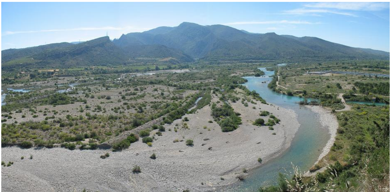
Figura 55-15. Cauce trenzado del Cinca agua abajo de El Grado.
