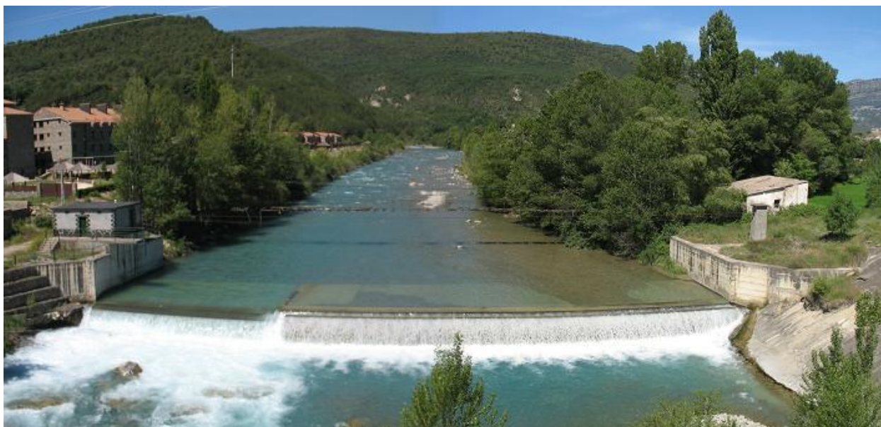
Figura 55-57. Estación de aforos del río Ara en Boltaña.
