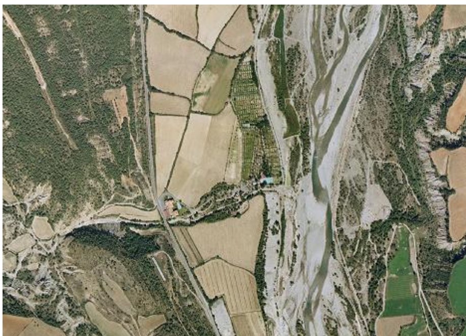
Figura 55-10. Defensas laterales en el río Cinca aguas arriba de Aínsa.
