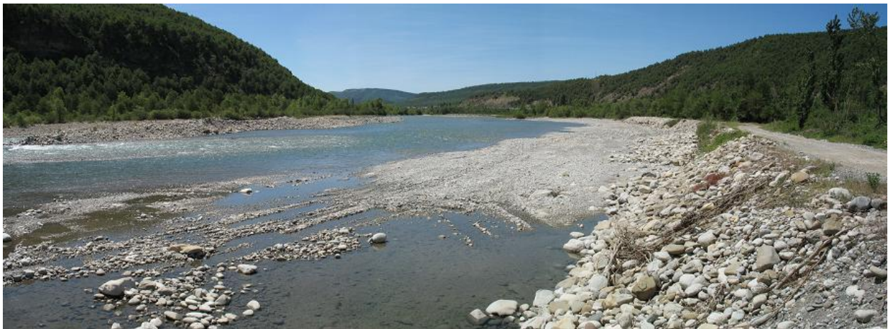
Figura 55-12. Dragado aguas arriba de Labuerda.
