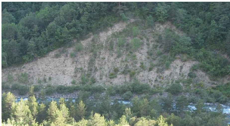
Figura 55-55. Defensa de margen en el río Ara aguas arriba de Fiscal.
