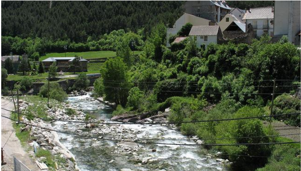
Figura 55-40. Río Barrosa en Bielsa. Defensas laterales.
