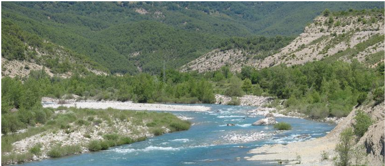
Figura 55-7. Escollera lateral en la margen izquierda del río Cinca aguas arriba de Laspuña.
