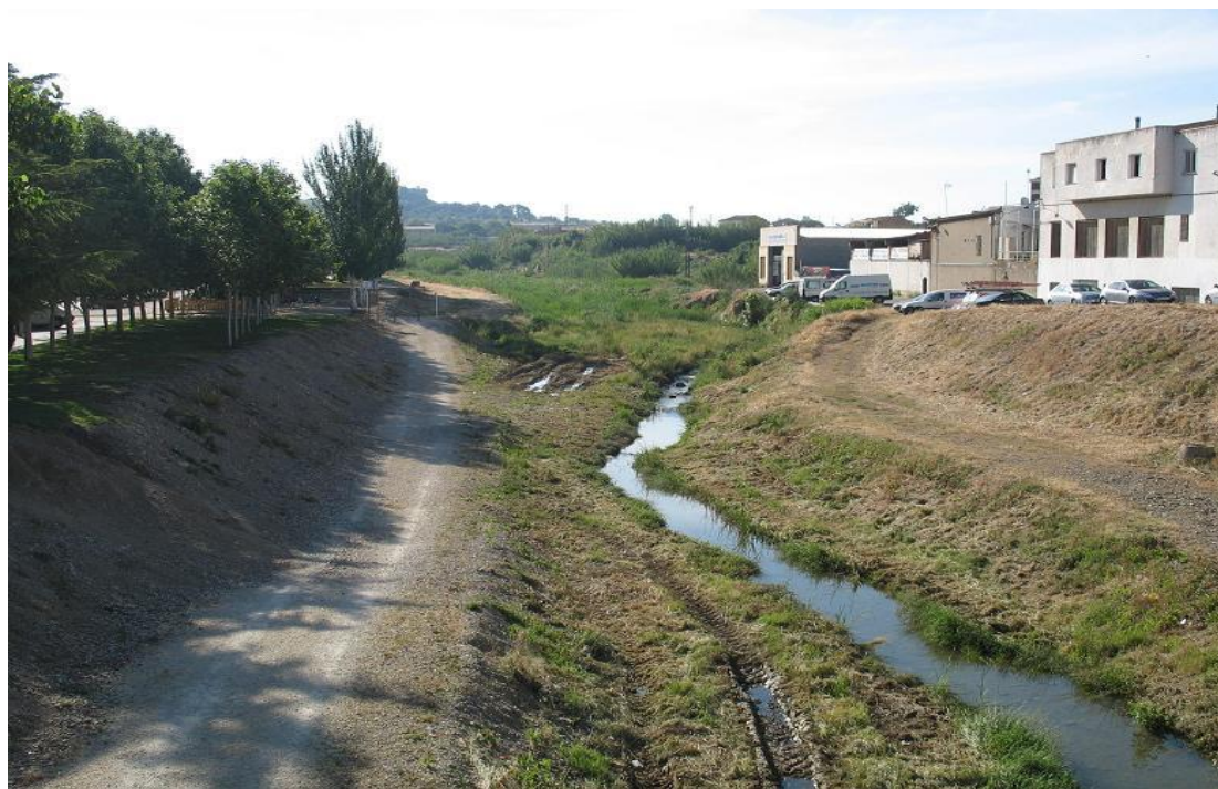
Figura 55-69. Río Sosa aguas arriba de la canalización de Monzón.
