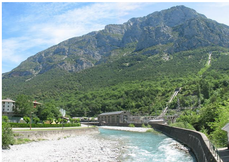
Figura 55-3. Río Cinca aguas abajo de la localidad de Lafortunada.
