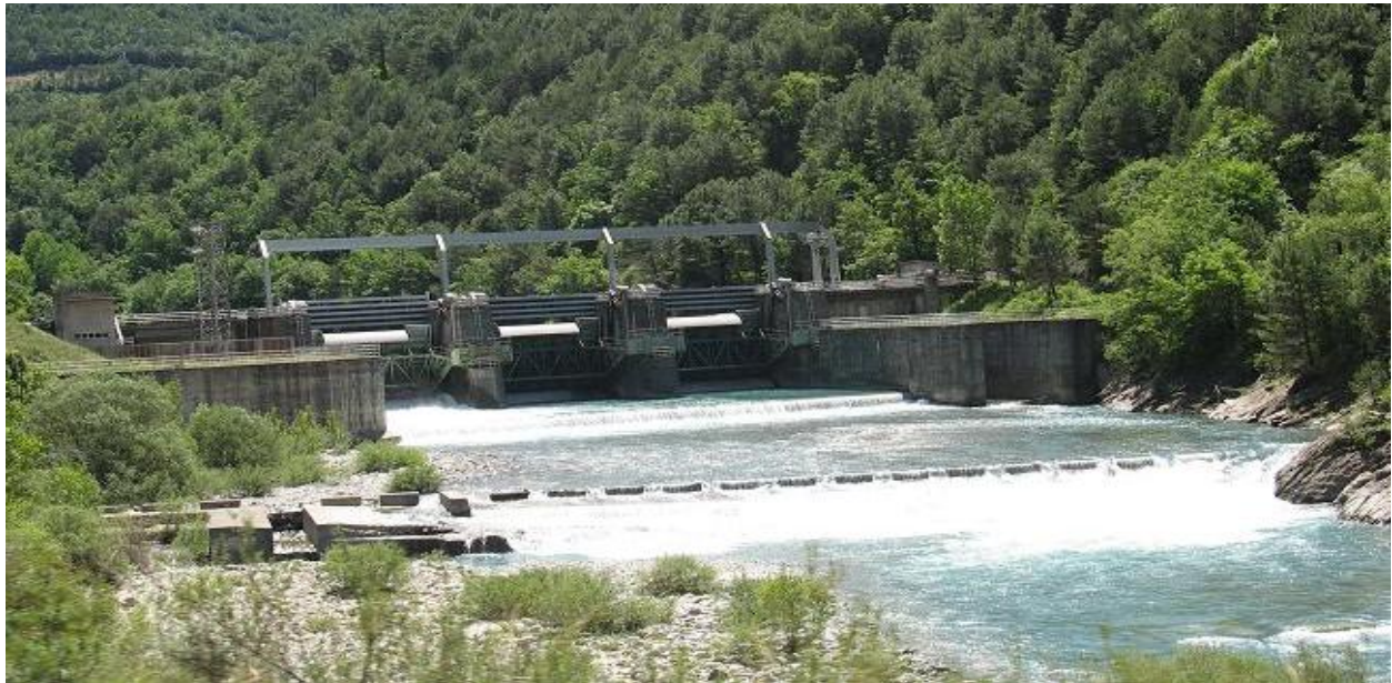
Figura 55-6. Presa de Lafortunada.
