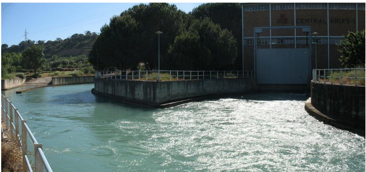
Figura 55-22. Canal de derivación de caudales para regadío e hidroelectricidad.
