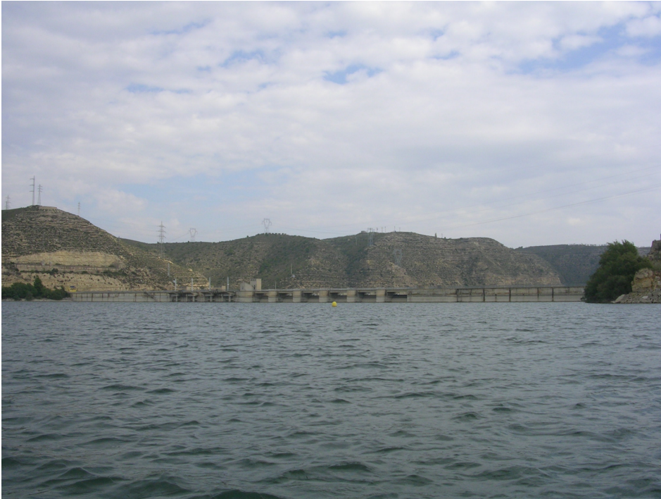
Figura 7. Vista de la presa del embalse
