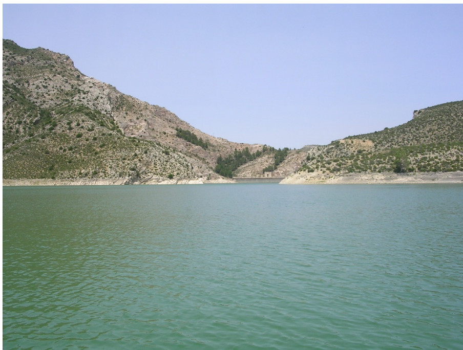
Figura 7. Vista de la presa del embalse
