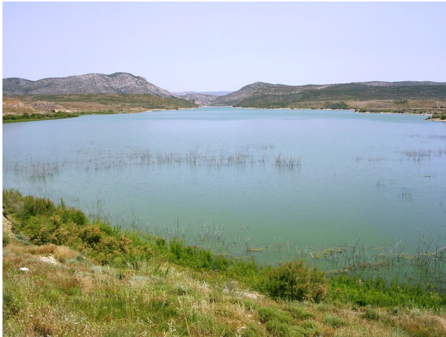
Figura 9. Vista desde la cola del embalse
