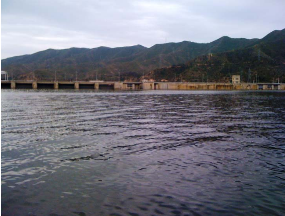
Figura 7. Vista de la presa del embalse
